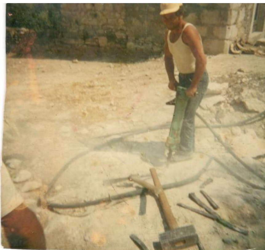
1968 - Lino Savelli, scavo per la fogna a Montenero
